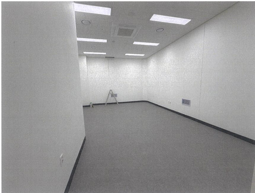
[ 일련번호(3) 내부 전경 ]
